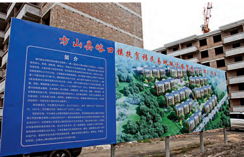
国开行山西分行贷款支持的吕梁市方山县易地扶贫搬迁项目施工现场
