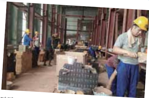
玻璃厂建设现场——北侧蓄热室施工
